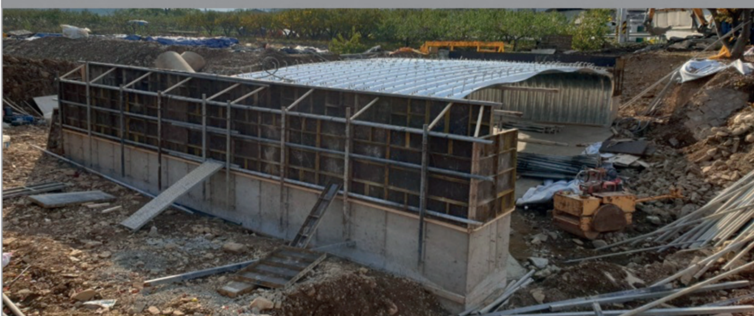
뒷채움토 대신 콘크리트 사용
