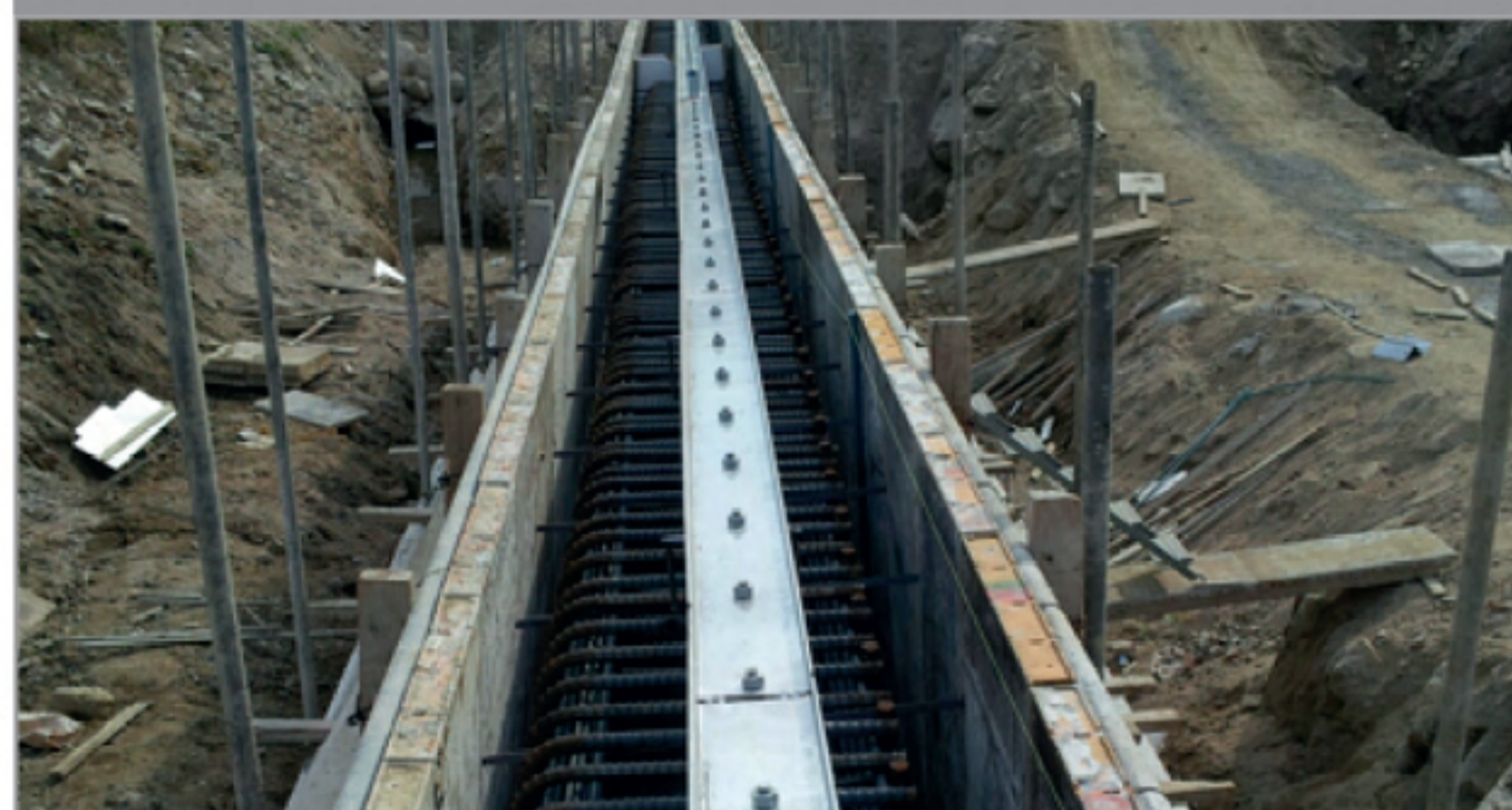
STEP 2 _ 파형강판 결합용 C형강 설치
