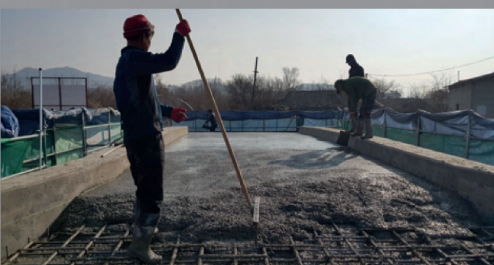
STEP 7 _ 응력이완 슬래브 타설
