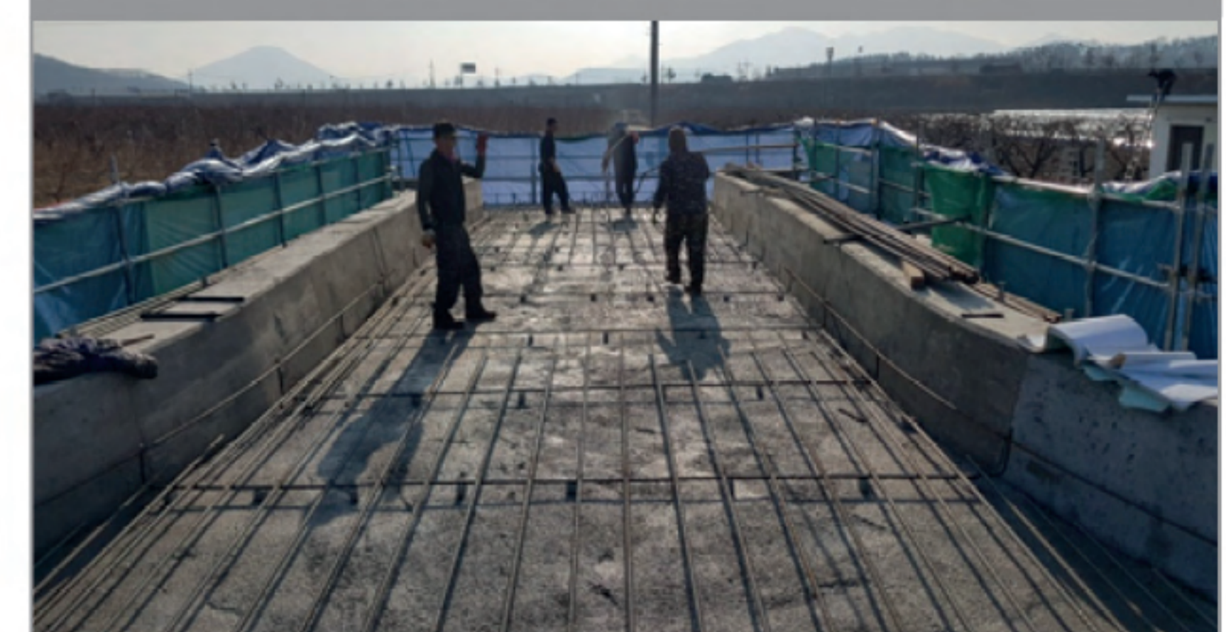
STEP 6 _ 응력이완 슬래브 배근
