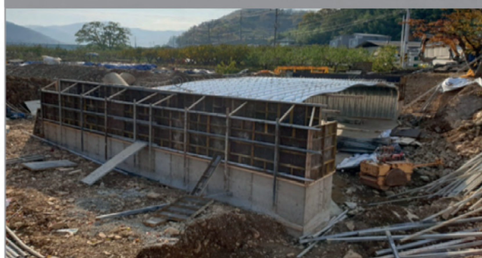
STEP 5 _ 측면 콘크리트 타설
